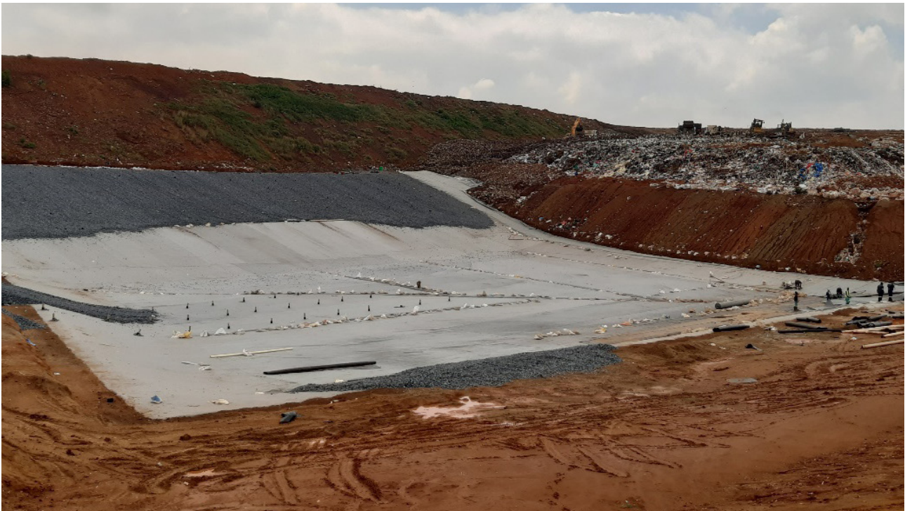
The Waste Group se klas B-voering ("liner") besig om voltooi te word by die Mooiplaats-vullisterrein in Centurion, Gauteng.
